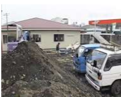
工事中のサポセン
